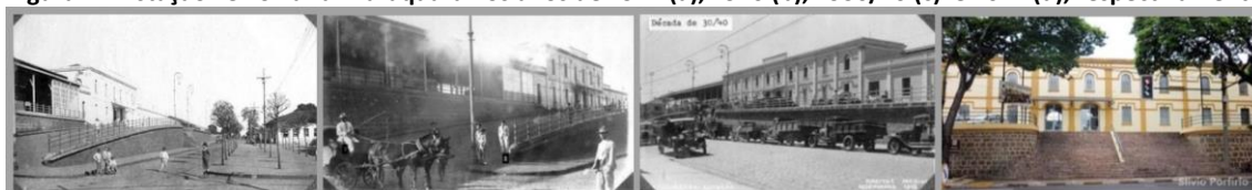
Figura 12. Estação Ferroviária Araraquara nos anos de 1914 (a), 1920 (b), 1930/40 (c) e 2017 (d), respectivamente
