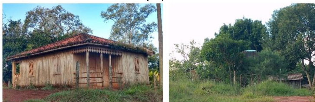
FIGURA 11: Edificações pertencentes a EEA e IF
