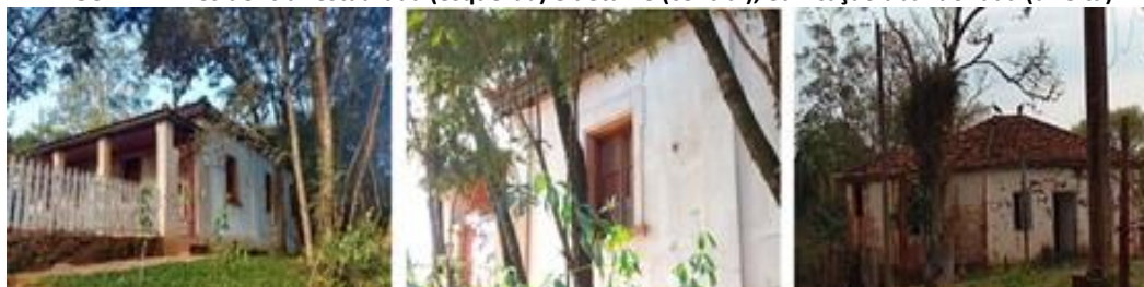
FIGURA 14: Residência restaurada (esquerda) e detalhe (central), edificação abandonada (direita)
