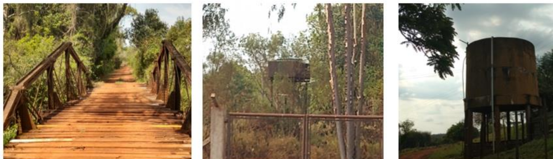
FIGURA 10: Remanescentes da ferrovia (Ponte Inglesa, Caixa d'água em ferro e Caixa d'água em concreto)
