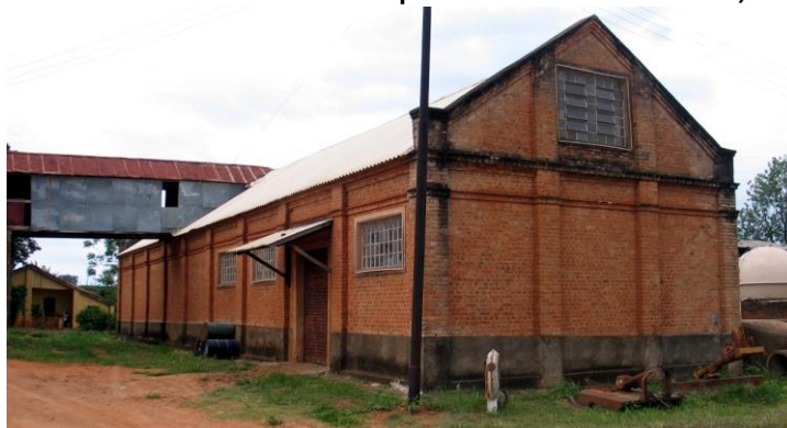
Figura 2 – Detalhe tulha e casa de máquinas da Fazenda Guaiuvira, Guarantã
