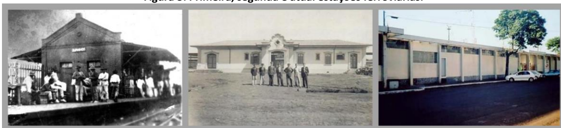
Figura 3: Primeira, segunda e atual estações ferroviárias.
