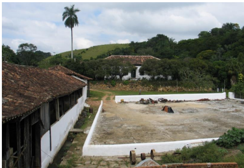
Figura 2 – Vista atual dos terreiros, com o casarão ao fundo.
