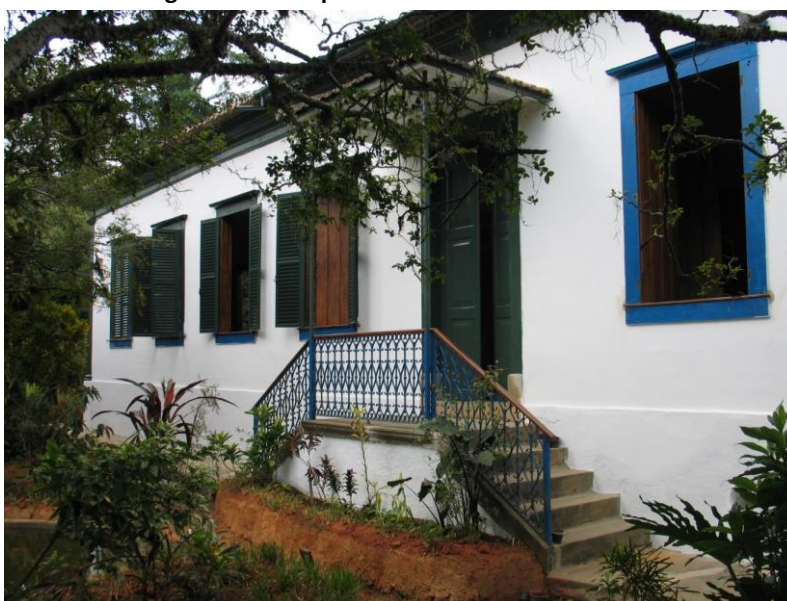
Figura 3 – Vista parcial da fachada do casarão.
