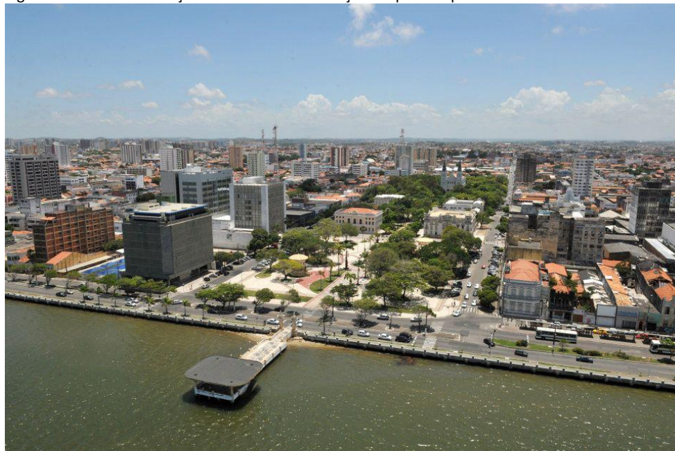
Figura 01 – Vistas das Praças Fausto Cardoso e Praça Olímpio Campos no Centro da cidade de Aracaju (SE)
