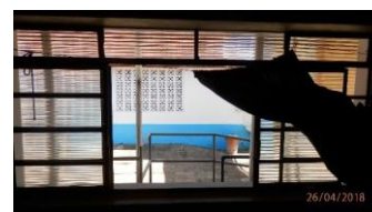
Figura 4: Janela do setor 2, da ILPI 1 - iluminação e privacidade.
