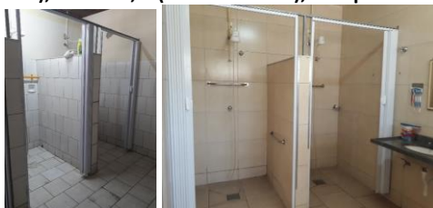
Figura 8: Piso cerâmico liso (banheiro masculino - Setor C), à direita, e (Setor 2 - ILPI 2), à esquerda.
