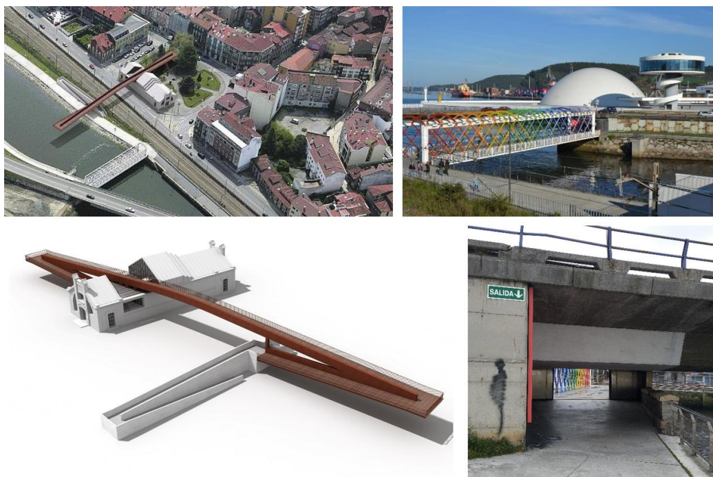
Figura 13. As passarelas e o acesso ao Centro Cultural Internacional Oscar Niemeyer
