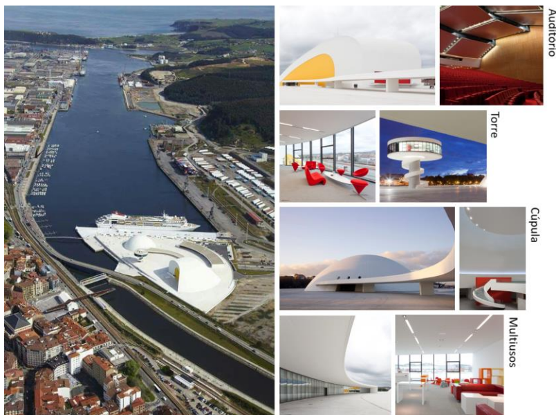
Figura 12. Imagem aérea e imagens dos edifícios do Centro Cultural Internacional Oscar Niemeyer
