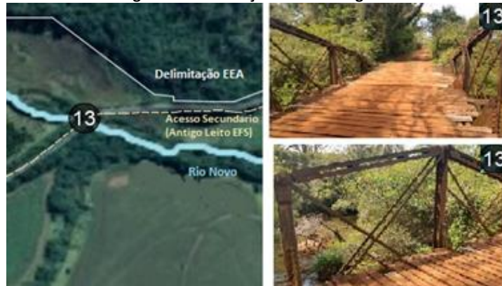
Figura 17: Localização e Ponte “Inglesa”
