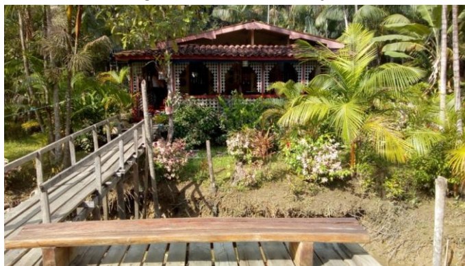
Figura 3: Fachada da habitação
