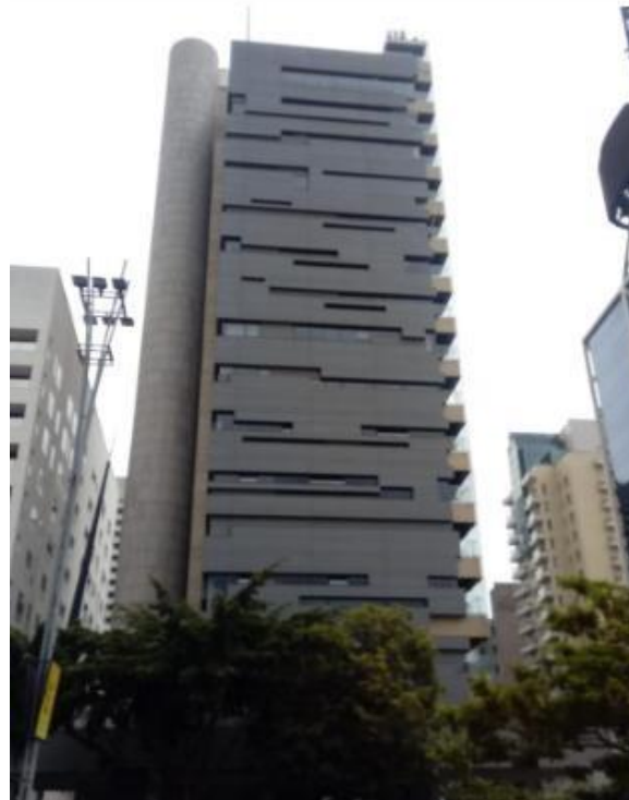
Figura 4 – Fachada do Edifício SESC Paulista.
