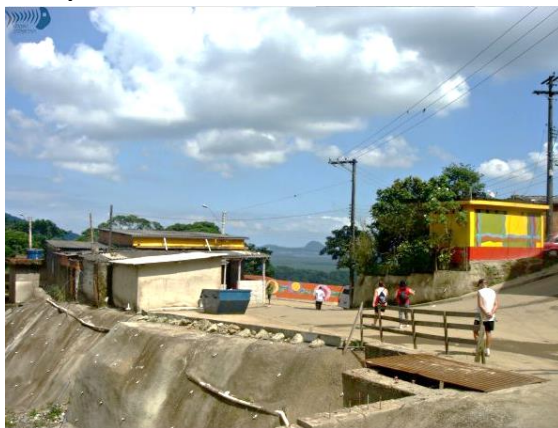
Figura 13 - Cota 200: Execução de obras de contenção de taludes
