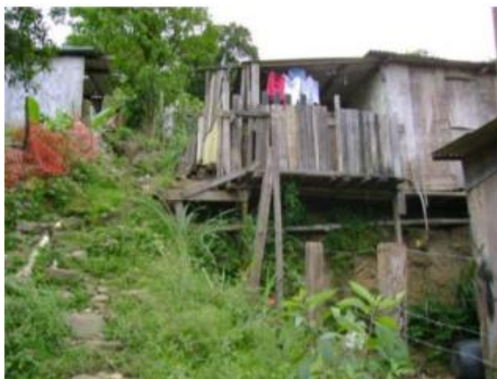
Figura 10 - moradias que ocupavam a encosta do Bairro Cota 95-100
