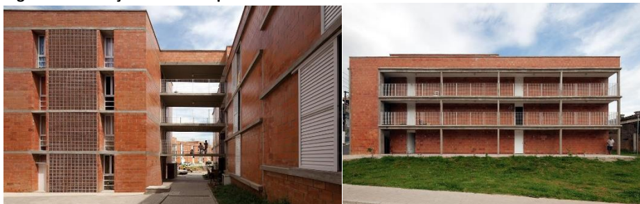
Figura 8: Circulação edifícios – passarelas.
