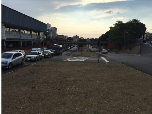
Ponto 10 – Av. Trabalhador Sancarlense sobre o córrego tamponado vista de montante à jusante
