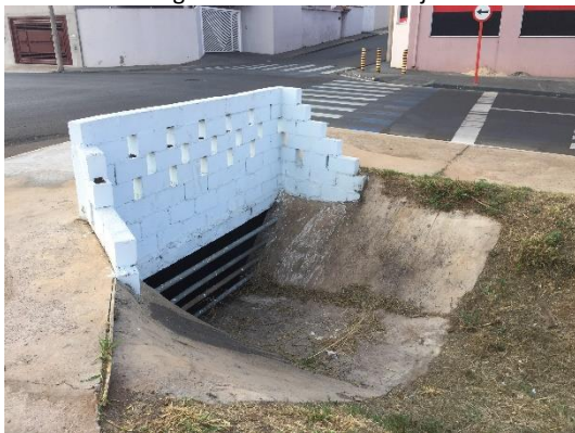
Ponto 8a – Estrutura drenante em trecho tamponado do córrego visto de montante à jusante
