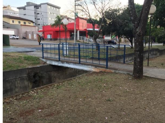
Ponto 12 – Travessia de pedestres sobre o córrego canalizado vista de montante à jusante
