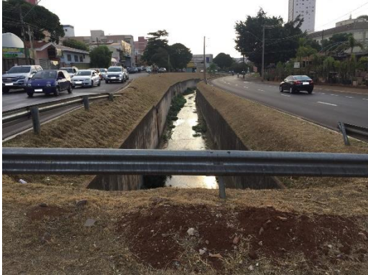
Ponto 11 – Transição entre os trechos 2 e 3 vista de montante à jusante
