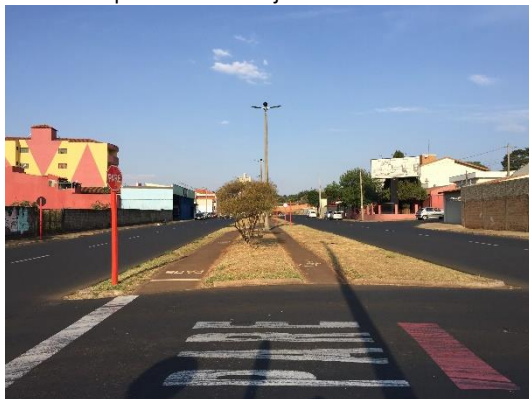
Ponto 8b – Ciclovia implantada sobre o córrego tamponado vista de jusante à montante
