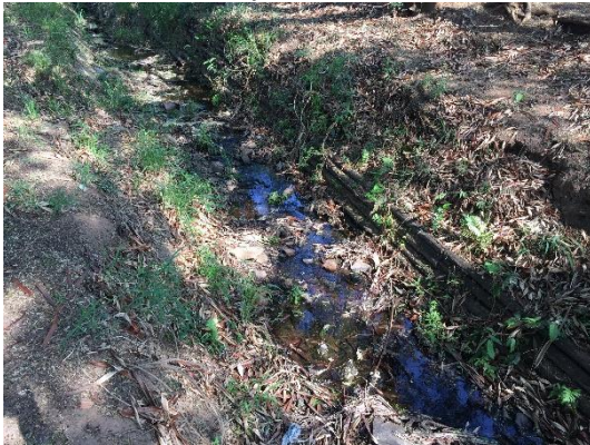
Ponto 2b – Leito do córrego dentro do parque linear do Tijuco Preto
