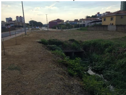
Ponto 7b – Início do tamponamento do córrego visto de montante à jusante
