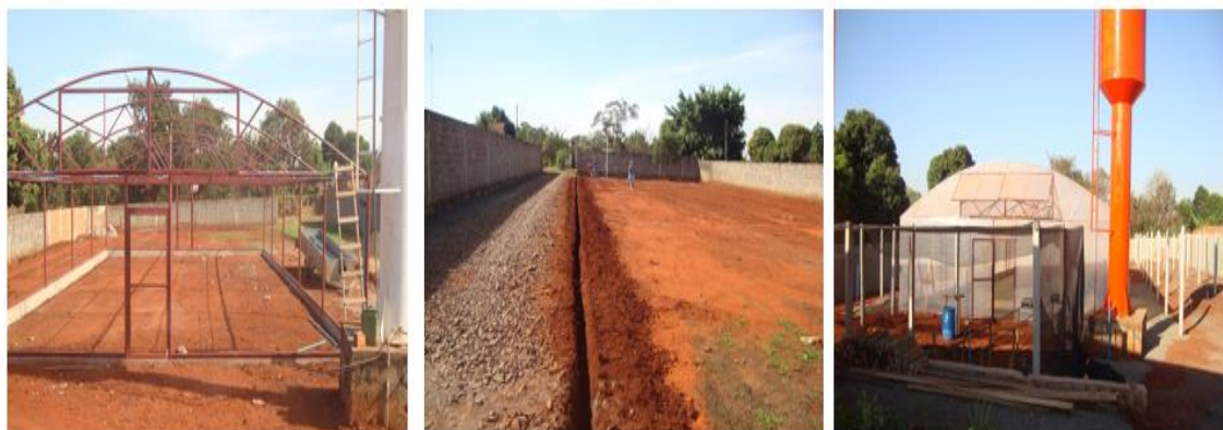
Figura 2 - Imagens das fases da construção do Viveiro Municipal “Flora do Cerrado”, Campo Grande, Mato Grosso do Sul
