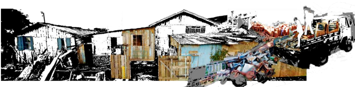
Figura 9 - A demolição das arquiteturas em madeira.
