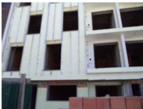
Figura 6. Detalhe do isolamento Térmico no exterior
