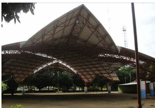
Figura 05: Cobertura localizada na Praça G. Dias
