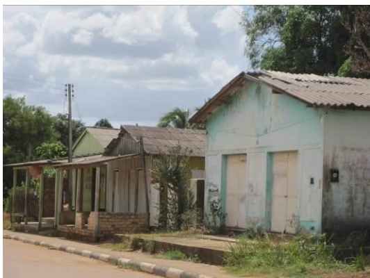
Figura 03: Avanços das testada de edificações
