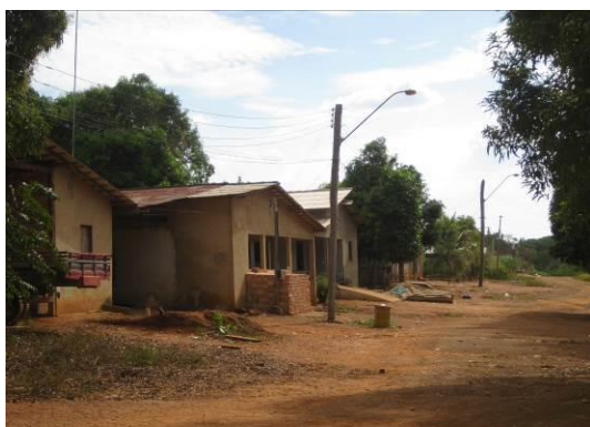
Figura 07: Rua Zeferino Gomes sem infraestrutura
