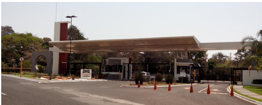
Figura 7 - Portaria Villaggio II. Fonte: Criado pelo autor.
