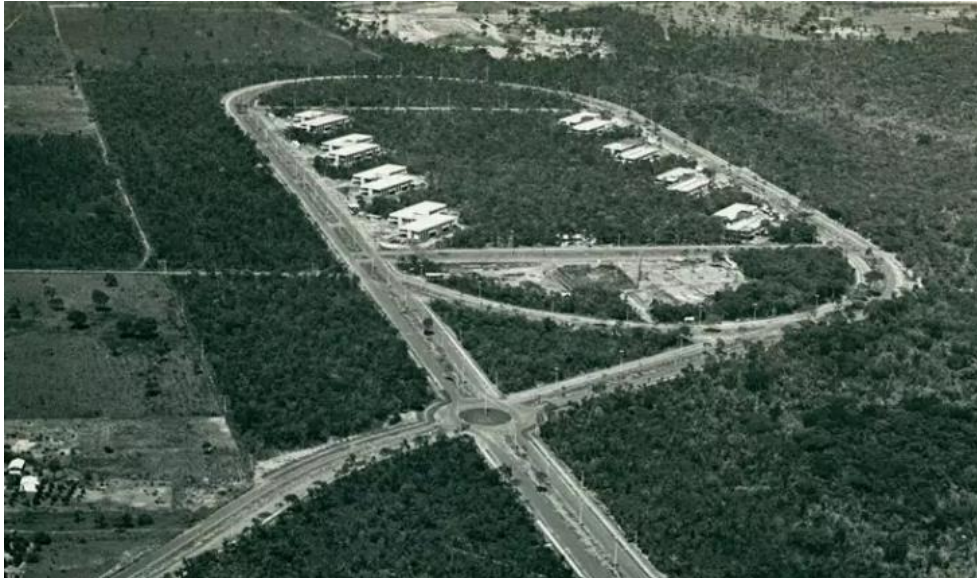
Figura 2 – Vista aérea do Parque dos Poderes: vias e edifícios executados em meio ao remanescente florestal
