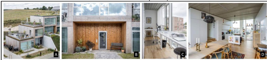
Figura 9 – Fotografias do Edifício Residencial Sneglehusene (A: Imagem externa, mostrando os módulos em concreto revestidos em madeira, alguns terraços e telhados verdes. B: Imagem externa, mostrando os revestimentos em madeira e fechamentos com vidros duplos. C e D: Imagens internas, mostrando pisos em madeira e tetos em concreto aparente).
