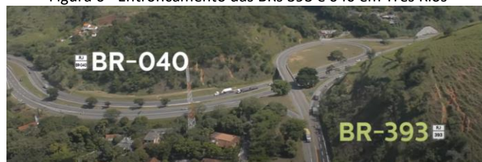
Figura 6 - Entroncamento das BRs 393 e 040 em Três Rios
