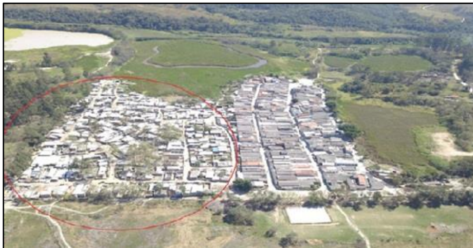
Figura 2 - Vista do Aglomerado Subnormal Lagoa Azul 2 realizada por drone
