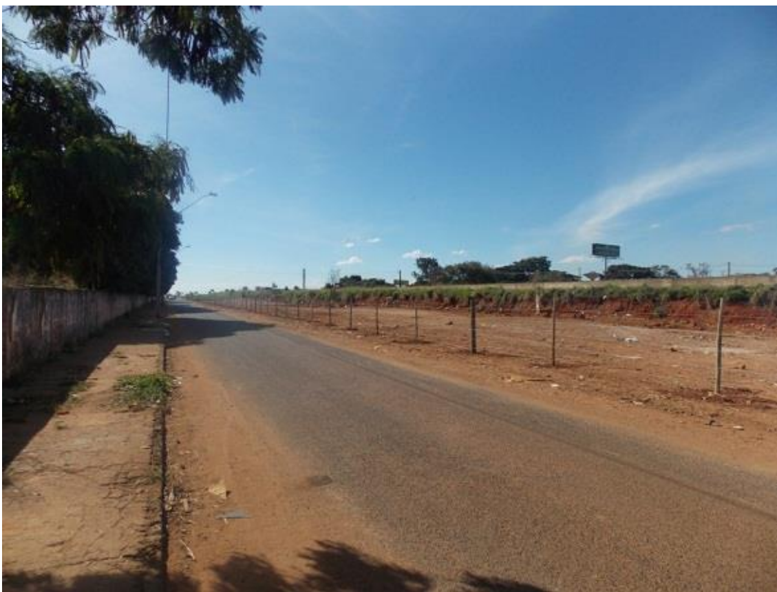
Figura 5 - Cerca no antigo Ponto Crítico do Bairro Segismundo Pereira Fonte: autora
