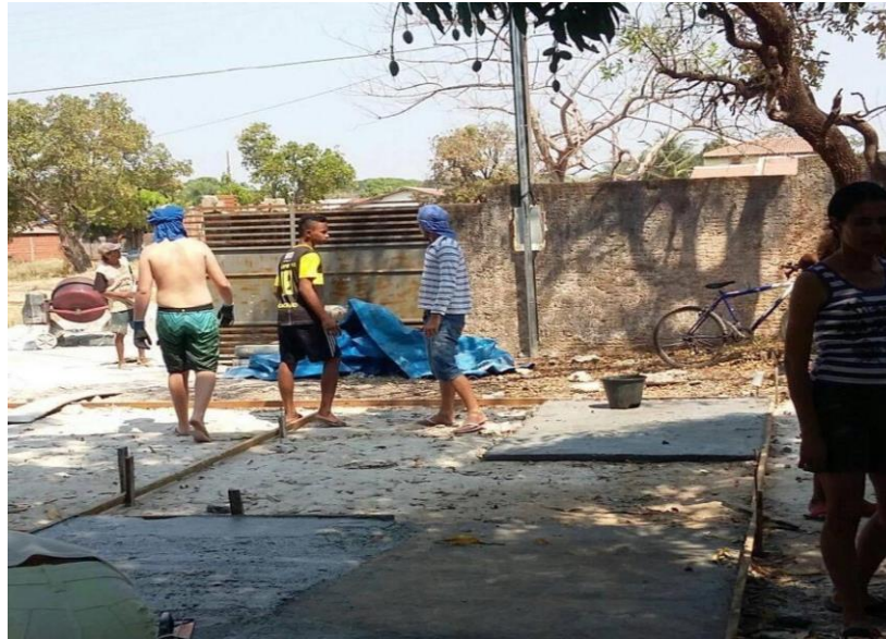
Figura 3 – Mutirão para construção do quintal do grupo Flor de Atalaia.
