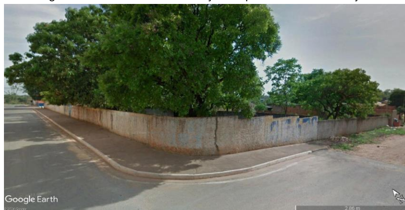
Figura 4 – Vista externa da localização do quintal antes da edificação.
