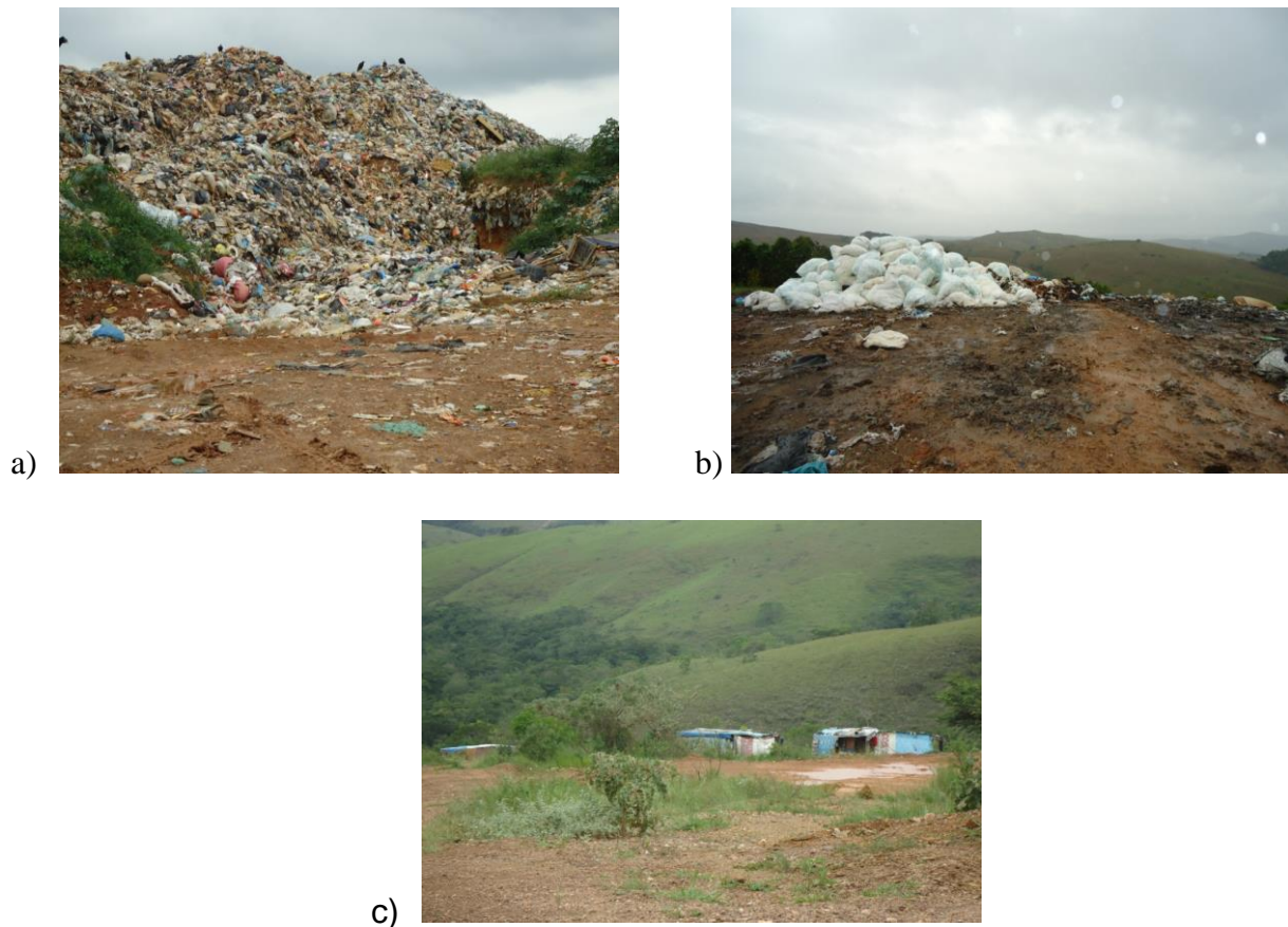
Figura 06: a) Lixo lançado in natura em solo sem proteção; b) evidências de queimadas; c) residências irregulares na área do lixão.
