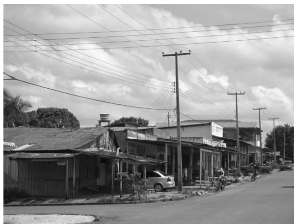
Figura 03: Avenida Dra Yandara com as edificações presentes de sua gênese com poucas modificações
