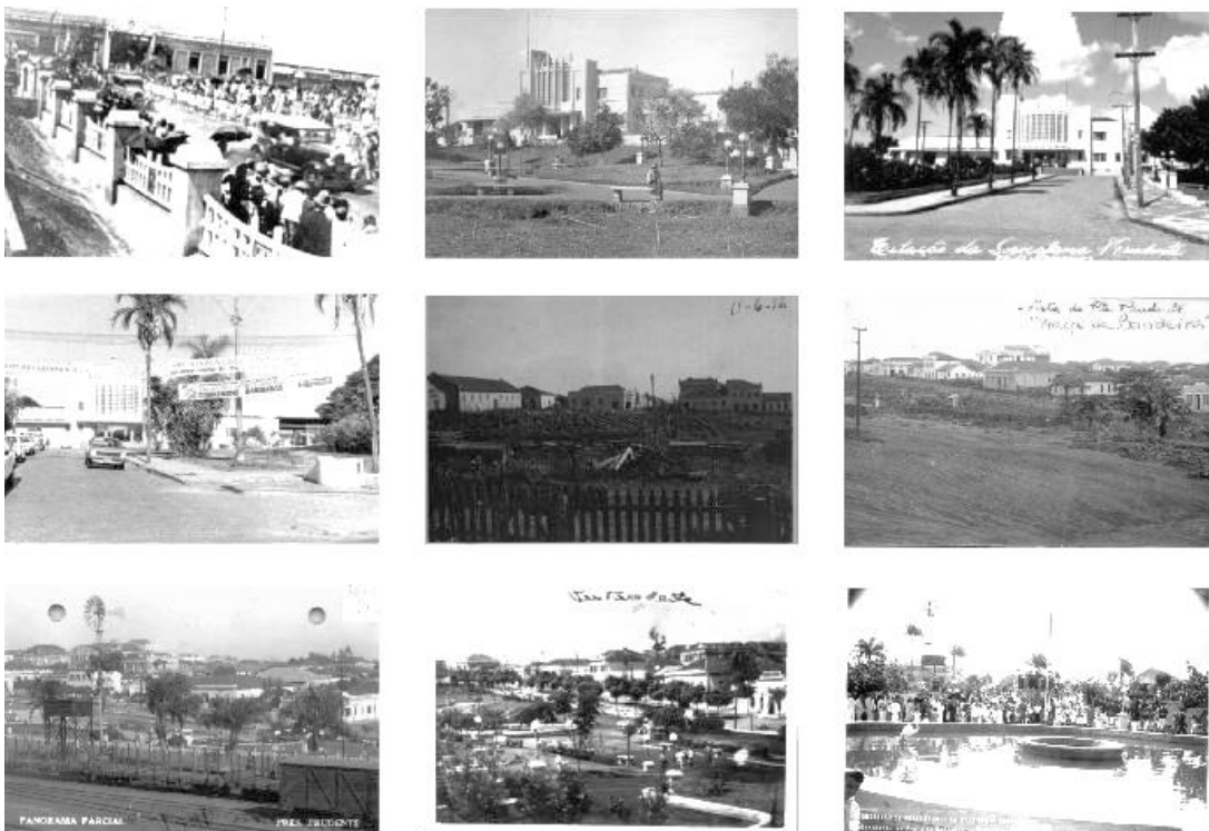
Figura 03 a 11: Imagens da Vila Goulart – acima: antiga Estação Ferroviária de 1926, o atual prédio de 1950 e, abaixo: casario e Praça das Bandeiras
