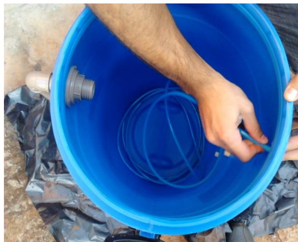
Figura 2: Interior das composteiras, mostrando a tubulação por onde será injetado o ar.
