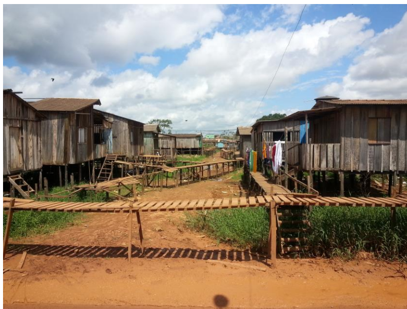
Fig. 01 – Padrão de Construção das Palafitas – Invasão dos Padres Fonte: Trabalho de Campo
