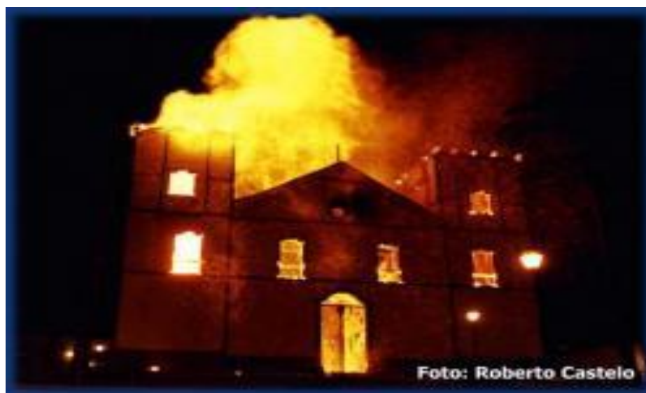
FIGURA 3. IGREJA NOSSA SENHORA DO ROSÁRIO NO DIA DO INCÊNDIO
