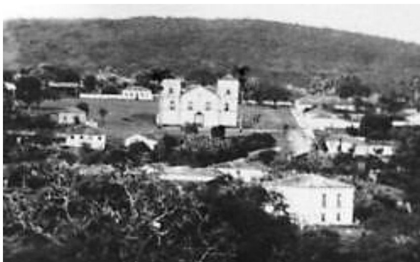
FIGURA 2. IGREJA NOSSA SENHORA DO ROSÁRIO ANTES DO INCÊNDIO
