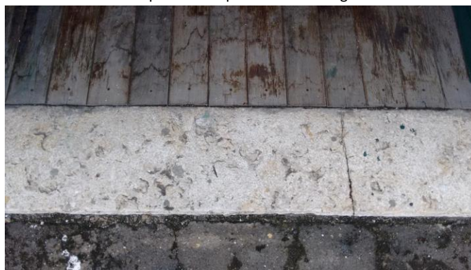
Figura 5: Batente em mármore da porta da Capela. Notar o desgaste no assoalho devido à chuva
