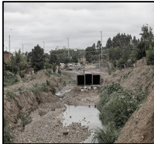
Figura 6 – Av. Parque do Barbado – durante a obra
