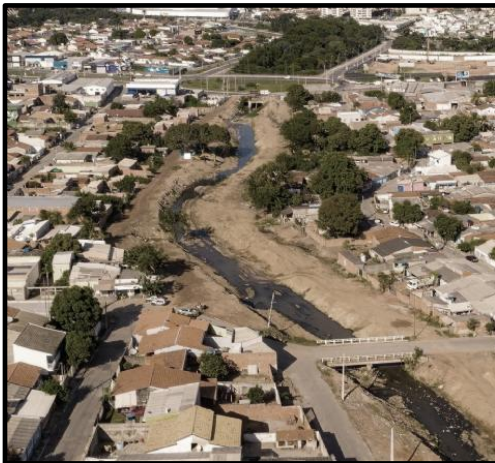
Figura 5 – Av. Parque do Barbado antes da obra
