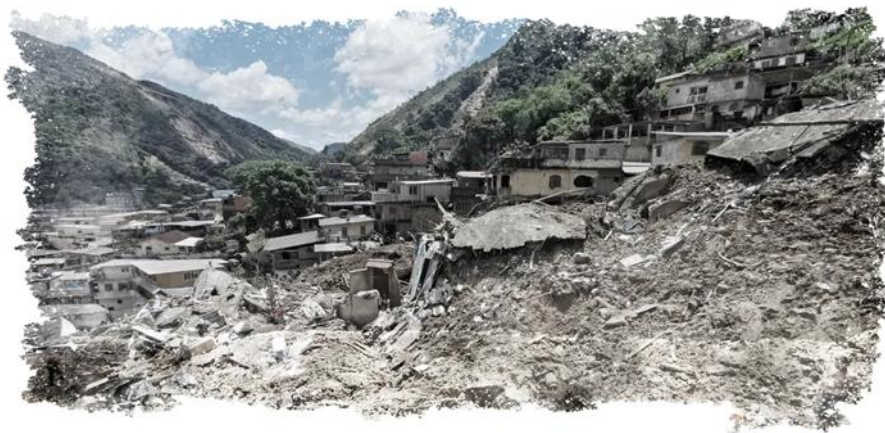
Figura 2 – Desastre socioambiental Petrópolis – Morro da Oficina – 2022
