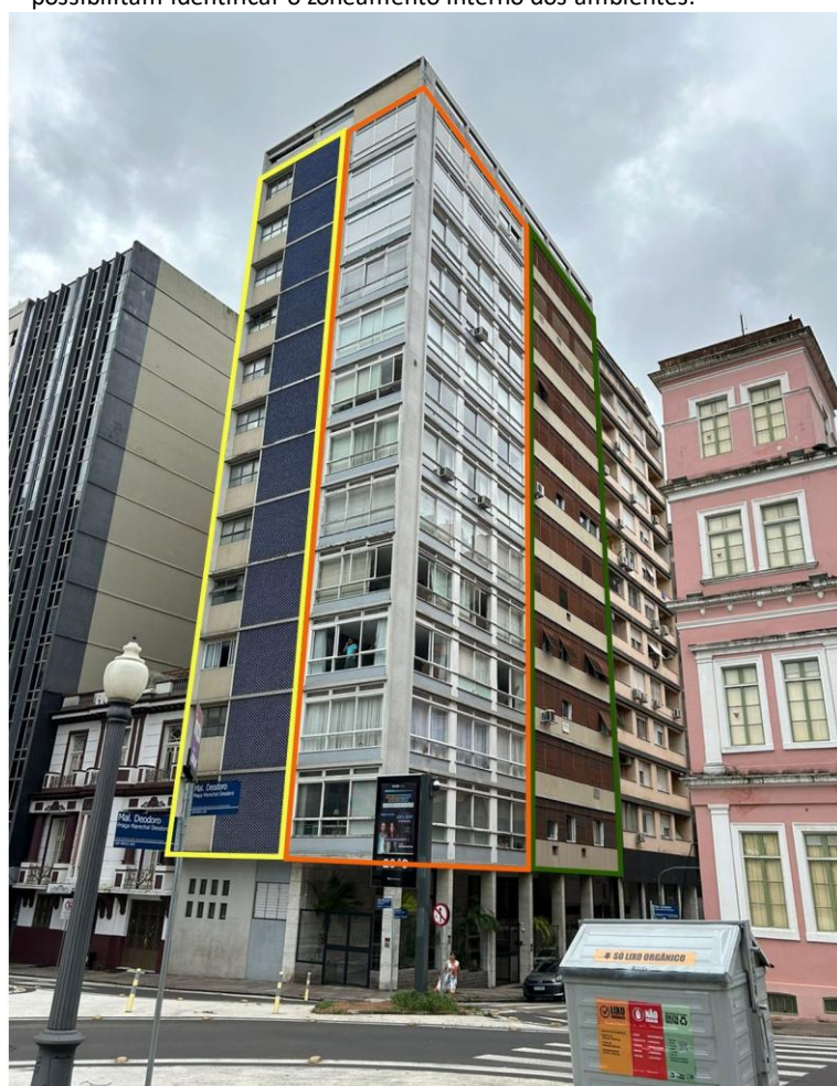
Figura 08 – Mapeamento dos diferentes tratamentos de fachada presentes no edifício Faial que possibilitam identificar o zoneamento interno dos ambientes.
