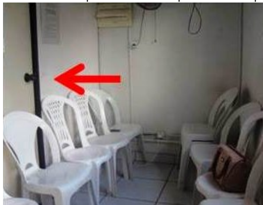
Figura 08: Puxador tipo bola e cadeiras plásticas inadequados
