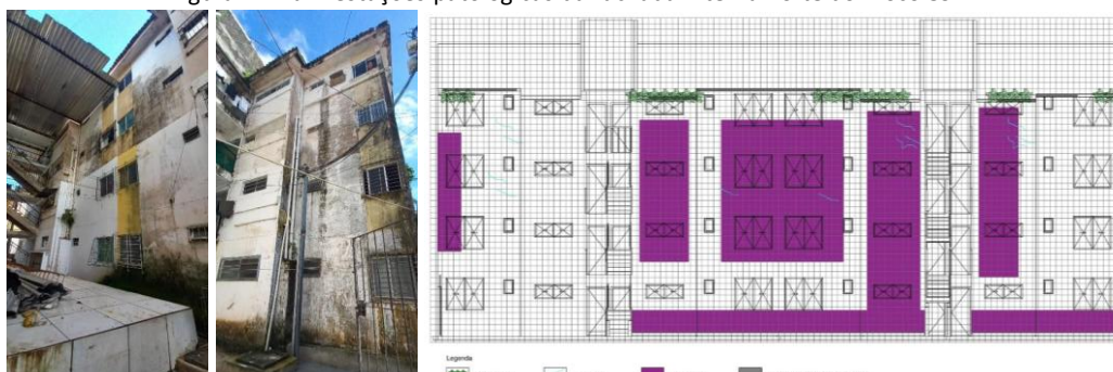
Figura 7- Manifestações patológicas da fachada interna norte do Bloco 89
