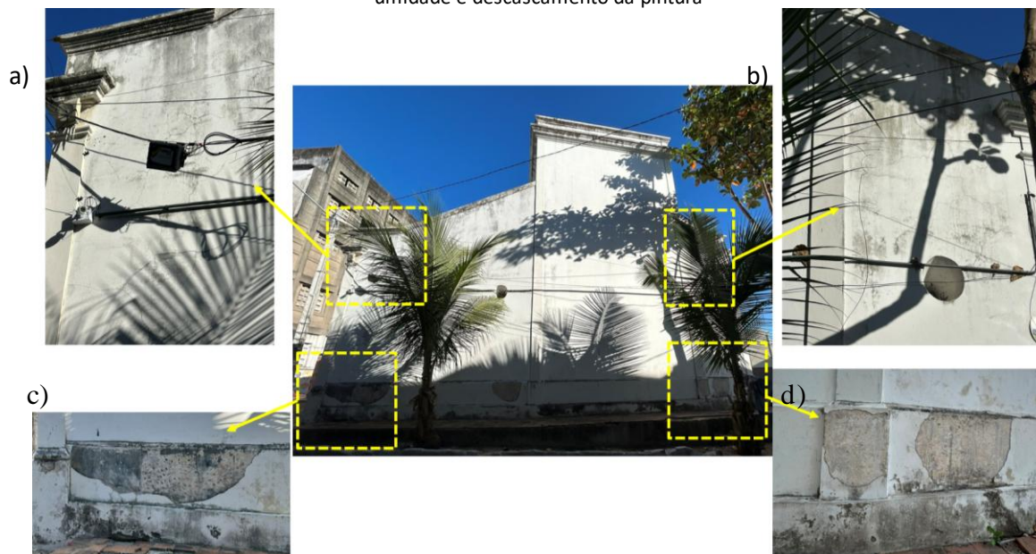
Figura 5 – Manifestações patológicas da fachada Norte: a) Sujidade/biofilme, fissuras b) Sujidade/biofilme, fissuras c) Sujidades/biofilme, manchas de umidade e deslocamento do revestimento d) Sujidades/biofilme, manchas de umidade e descascamento da pintura
