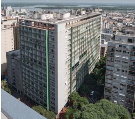
Figura 8 - Fachada em grelha, Ed. Esplanada, 1952, Porto Alegre.
