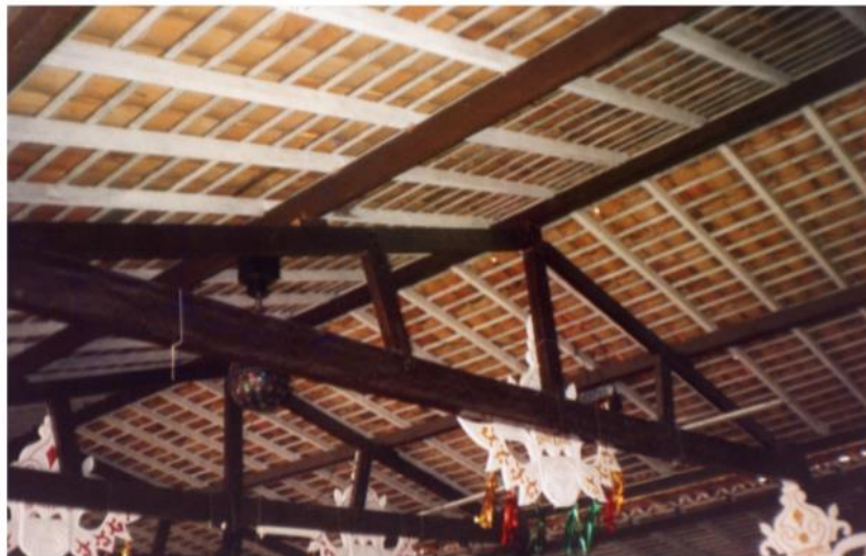
Figura 2: Cobertura em duas águas
