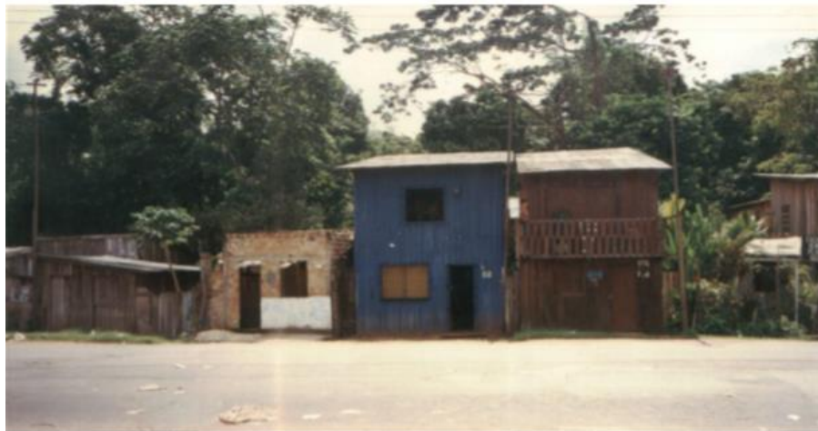
Figura 1: Habitações autoconstruídas na Avenida Perimetral
