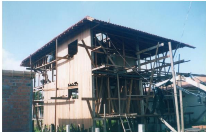
Figura 7: A casa em construção
