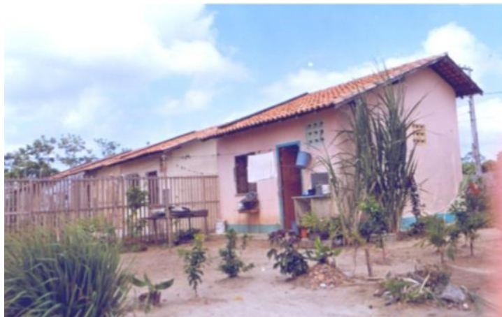
Figura 9: Unidade sanitária - fachada posterior
