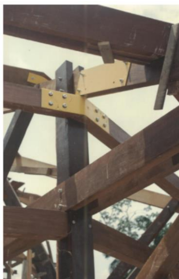
Figura 3: União de peças com chapas parafusadas
