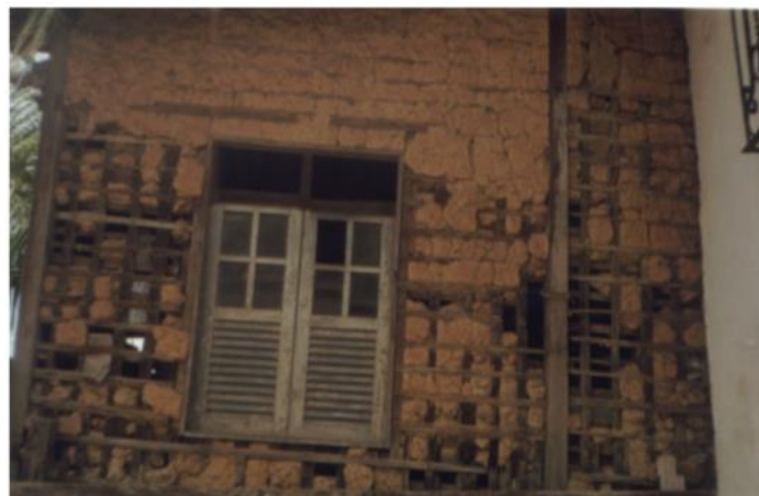
Figura 5: Exemplo de taipa em Belém
