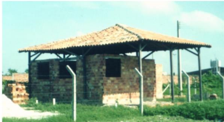
Figura 8: Construção das paredes independentes
