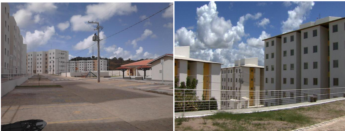
Figura 1 – Residencial Jaime Noberto e Residencial Zilda Arns em Aracaju, construídos pela faixa 01 do PMCMV na RMA.
