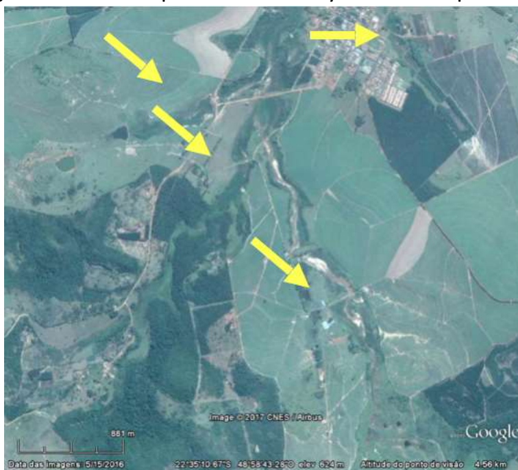
Figura 3: Imagen de satélite de 2016 que muestra la situación y los rastros de las presas después de la brecha
