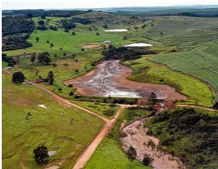
Figura 4: Fotografía aérea oblicua de 2016 que muestra la situación y el rastro de una de las presas después de la brecha.
