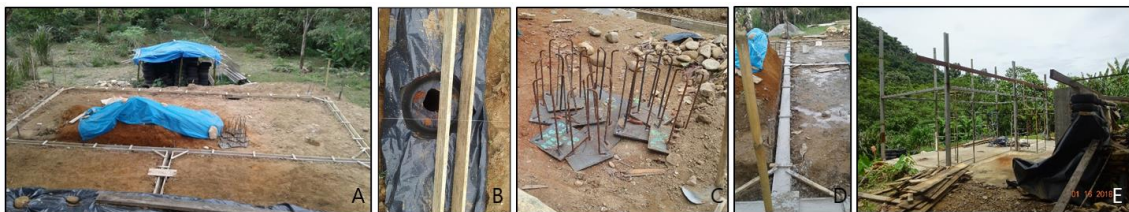
Figura 6: Fundação de pneus com terra batida com abertura de alicerce (A), chapas de aço para fixação (B), baldrame, concretagem e estrutura metálica
