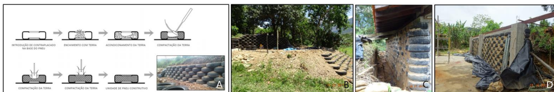
Figura 5: Operação de enchimento de parede-pneu, Sítio Arco Íris, Pindamonhangaba/SP
