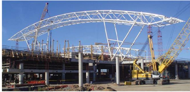
Figura 7: processo de montagem
