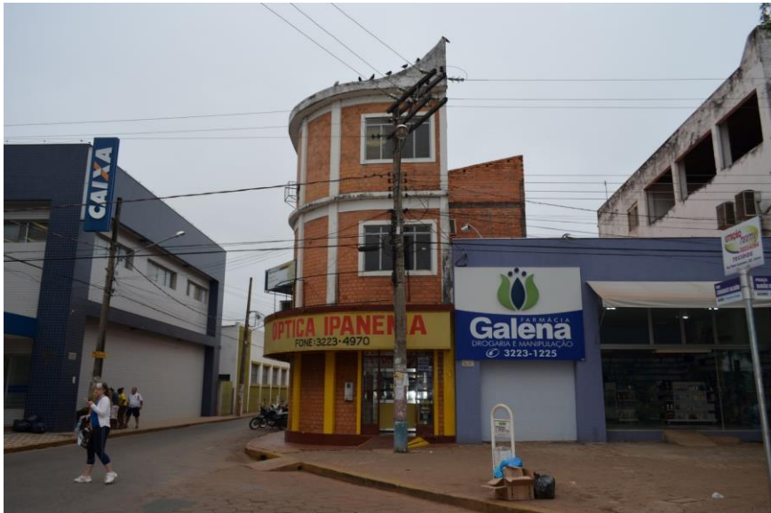
Foto 2 - Edificações com mais de 1 pavimento no entorno da Catedral de São Luiz, praça Barão do Rio Branco, Cáceres-MT.
