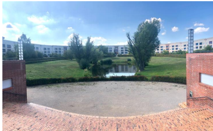
Figura 7: Großsiedelung Britz (Hufeisensiedelung)
