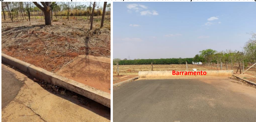
Figura 10: Estado atual do ponto de erosão C; obras de coleta e redução de velocidade da água
