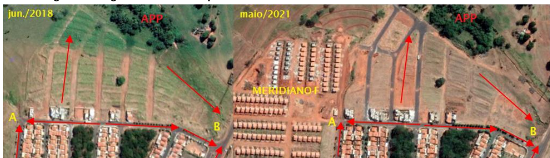
Figura 6: Imagem de satélite dos pontos A e B em 2018 e 2021 e sentido de caimento do terreno
