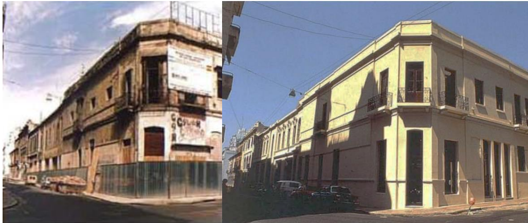
Figura 4: fachada antes e após a reabilitação
