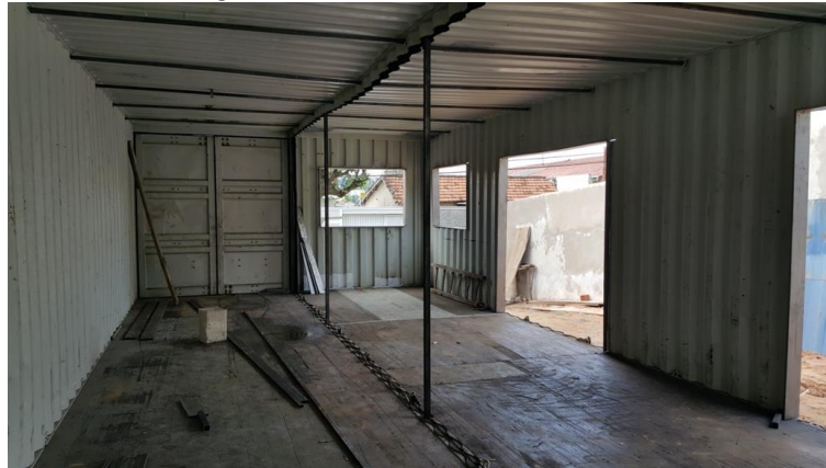
Figura 4: Abertura e união de contêineres
