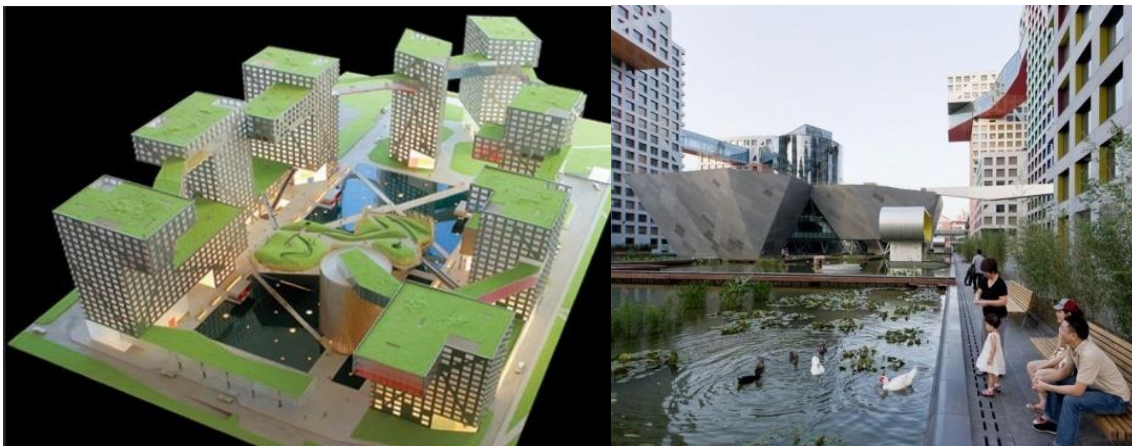
Figura 3 – Vista geral e detalhe do espaço interno do projeto Linked Hybrid – Beijing – China – Densidade > 1000 habitantes/hectare.
